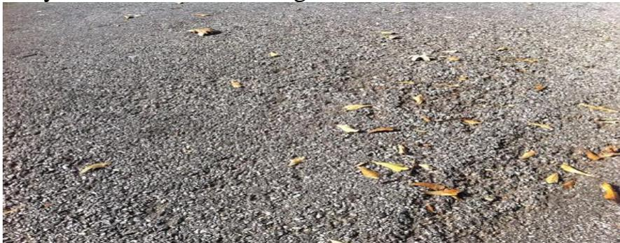
Fig. Raveling (very porous asphalt)
